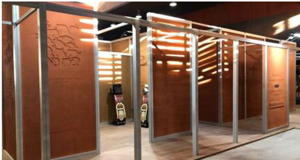
Imagen 34. Instalación del Pabellón.
